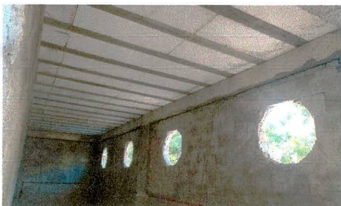
FOTO 09: Laje pré-moldado unidirecional
