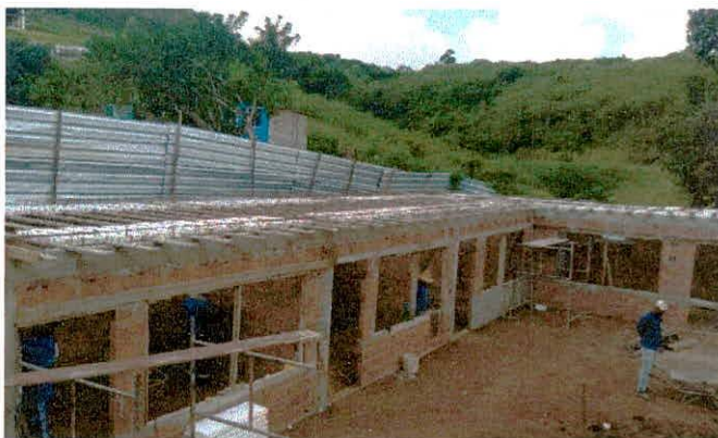
FOTO 10: Laje pré-moldado unidirecional
