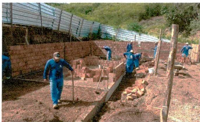
FOTO 08: Construções de quiosques/ WCs
