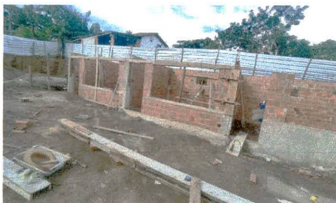
FOTO 07: Construções de quiosques/ WCs
