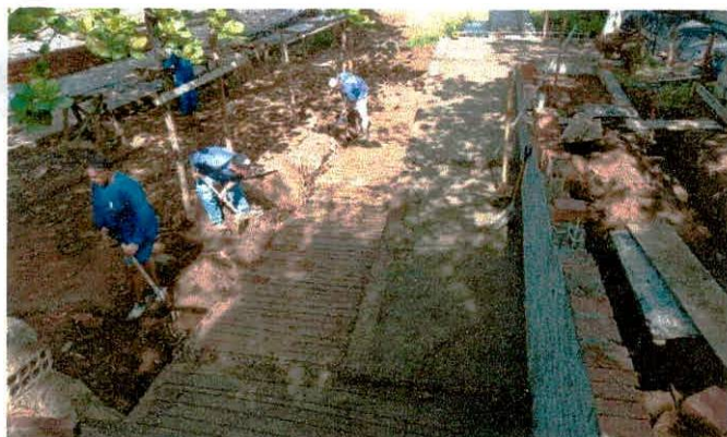
FOTO 03: Rampas de acessibilidade
