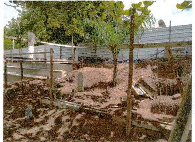
FOTO 08: Estrutura da arquibancada lateral
