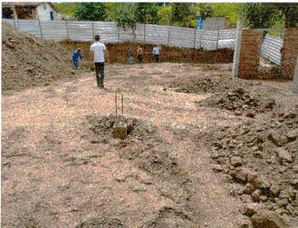
FOTO 09: Escavação área de alimentação
