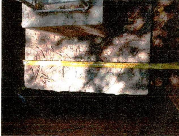
FOTO 01: Escavação/Sapata isolada 60 x 60 cm
