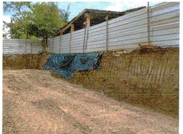
FOTO 10: Escavação área de alimentação
