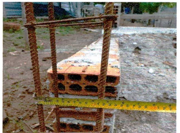
FOTO 06: Estrutura da arquibancada lateral
