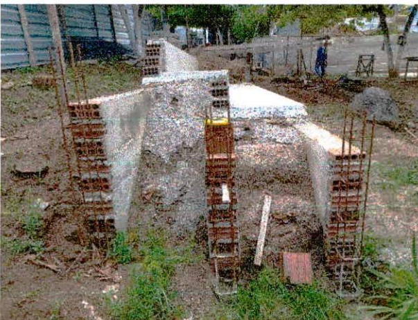
FOTO 05: Estrutura da arquibancada lateral
