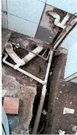
FOTO 1: Demolição de pisos para novos pontos;
