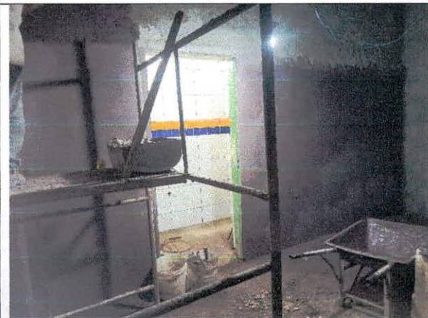
FOTO 18: Execução de revestimento em Barita;
