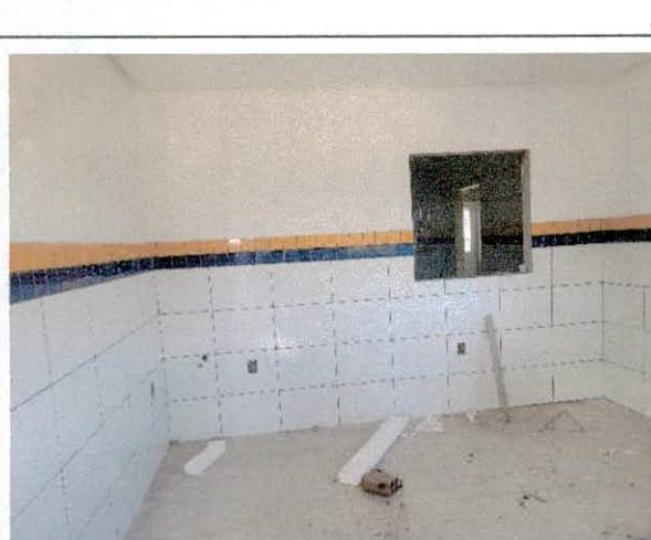
FOTO 29: Fundo selador e Emassamento - Anexo;
