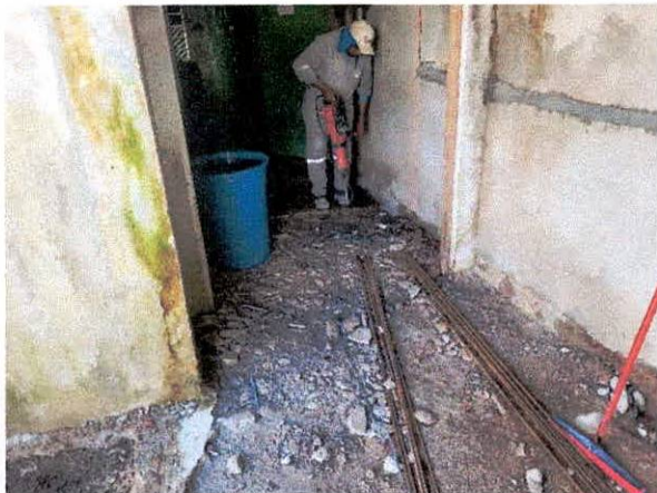
FOTO 3: Demolição de pisos granilite;
