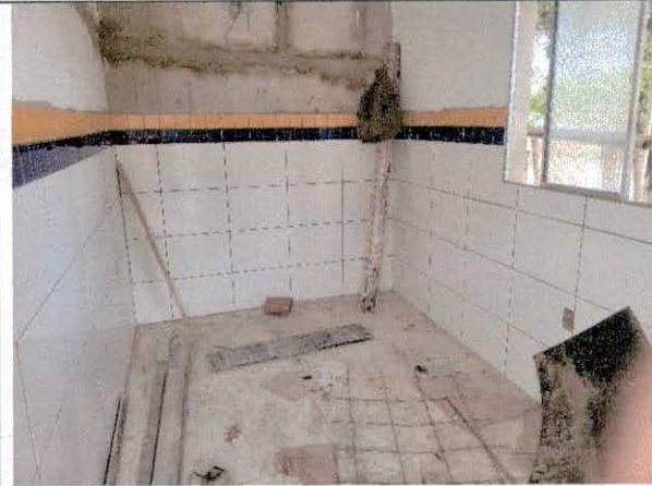
FOTO 20: Execução de revestimento cerâmico 10x10;
