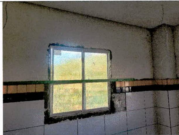
FOTO 32: Fundo selador e Emassamento - Anexo
