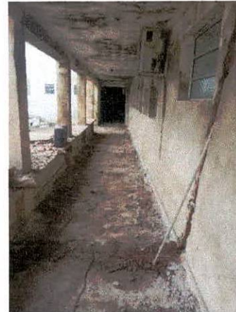
FOTO 4: Demolição de pisos granilites;
