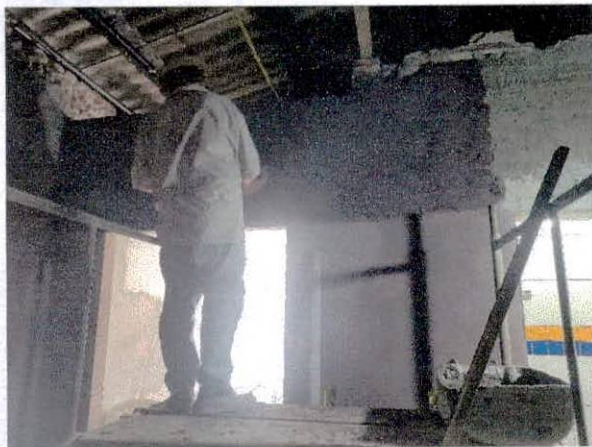
FOTO 19: Execução de revestimento em Barita;
