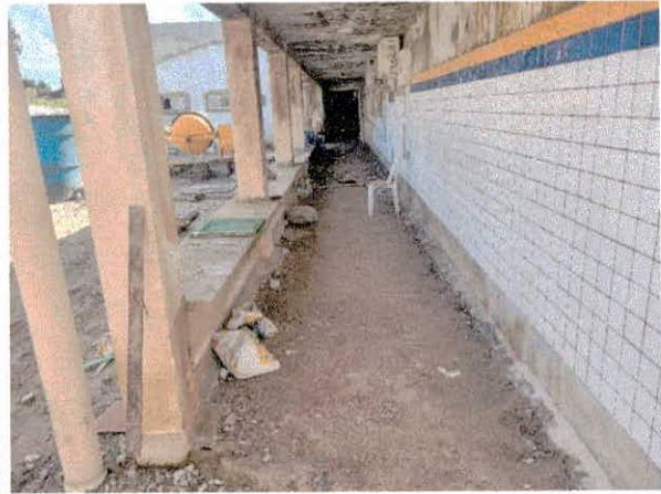
FOTO 20: Execução de revestimento cerâmico 10x10;
