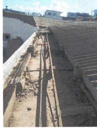
FOTO 2: Remoção de cobertura;
