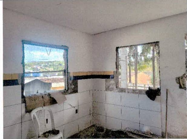
FOTO 28: Forro de gesso acabado e janela removidas;
