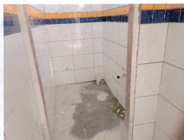
FOTO 21: Execução de revestimento cerâmico 10x10;
