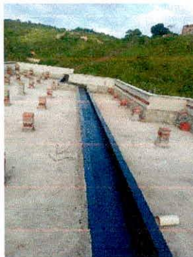
Foto 21: Impermeabilização de superfície calha
