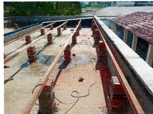
Foto 20: Estrutura da cobertura
