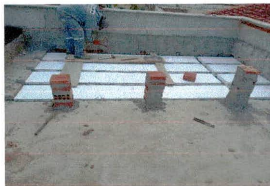
Foto 04: Execução de laje treliçada com enchimento eps
