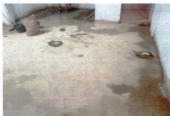
Foto 05: Execução de contrapiso
