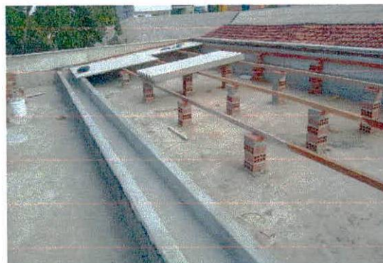
Foto 02: Estrutura da cobertura
