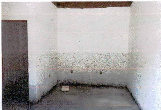
Foto 09: Execução de piso em granilite
