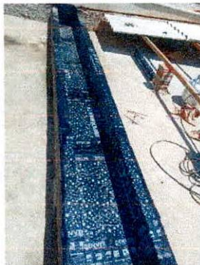
Foto 19: Impermeabilização de superfície calha
