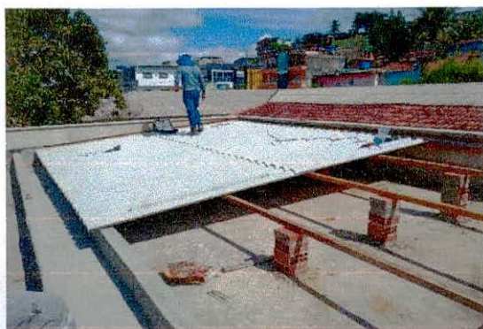
Foto 03: Execução de telhamento com telha ondulada de fibrocimento 6mm
