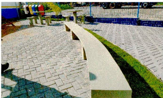
FOTO 01: Bancos de concreto finalizados e piso intertravado
