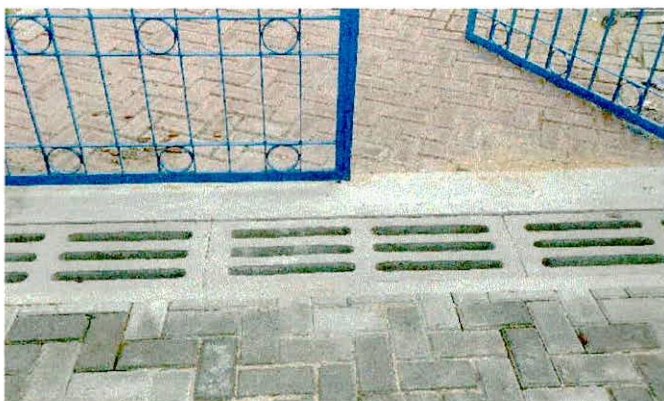
FOTO 05: Meio fio, gradil instalado e piso intertravado
