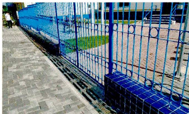
FOTO 06: Bancos de concreto finalizados e caixa de areia
