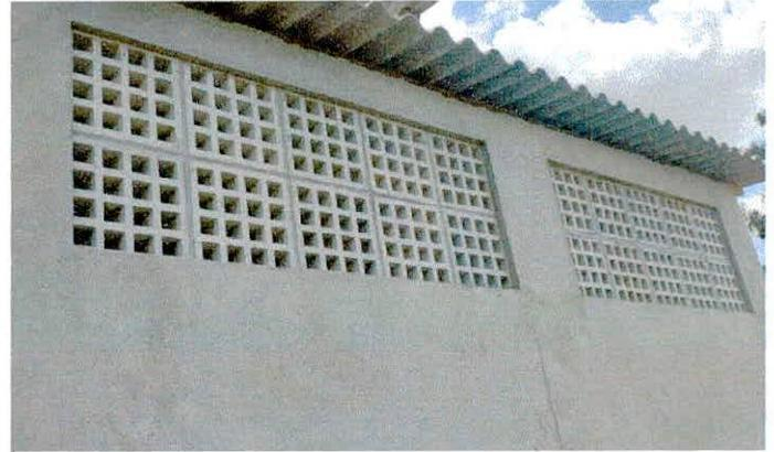
**FOTO 08:** Telhamento com telha ondulada de fibrocimento
