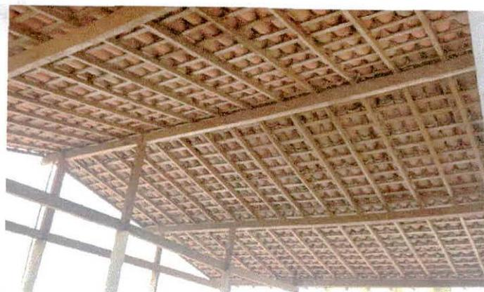
**FOTO 06:** Telhamento com telha cerâmica
