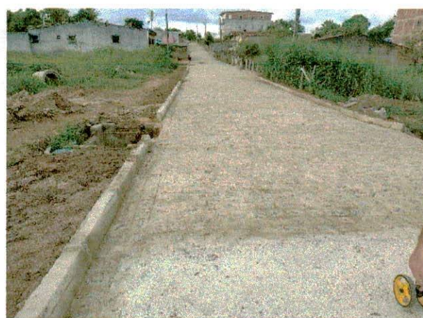
FOTO 08: EXECUÇÃO DE PAVIMENTAÇÃO
