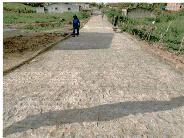
FOTO 06: EXECUÇÃO DE PAVIMENTAÇÃO
