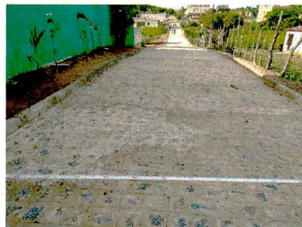
FOTO 04: EXECUÇÃO DE PAVIMENTAÇÃO
