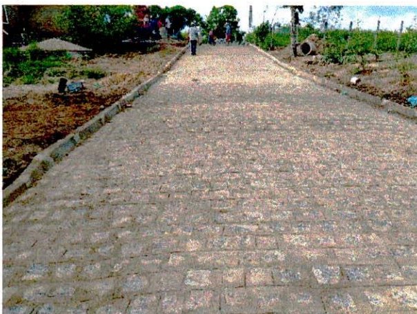
FOTO 11: EXECUÇÃO DE PAVIMENTAÇÃO
