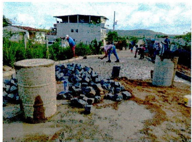
FOTO 12: EXECUÇÃO DE PAVIMENTAÇÃO
