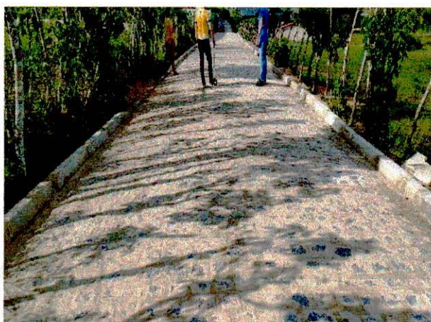
FOTO 01: EXECUÇÃO DE PAVIMENTAÇÃO
