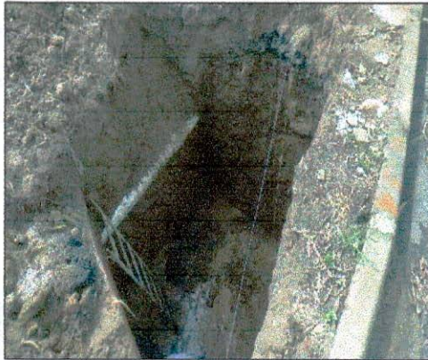
Foto 01: Escavação para fundação.
