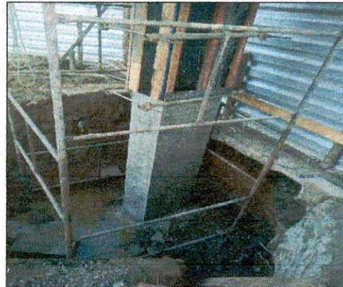
Foto 08: Execução de pilares.
