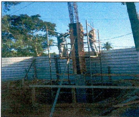
Foto 09: Execução de pilares.
