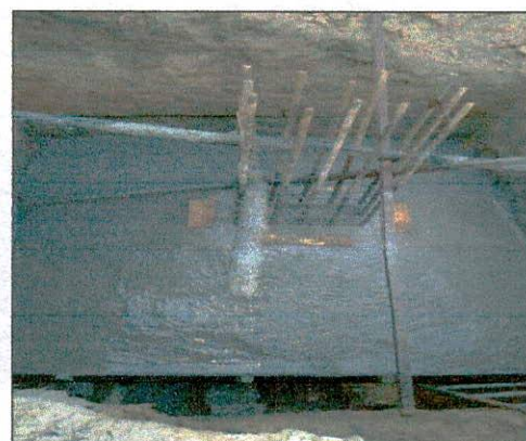
Foto 06: Sapatas concretadas.
