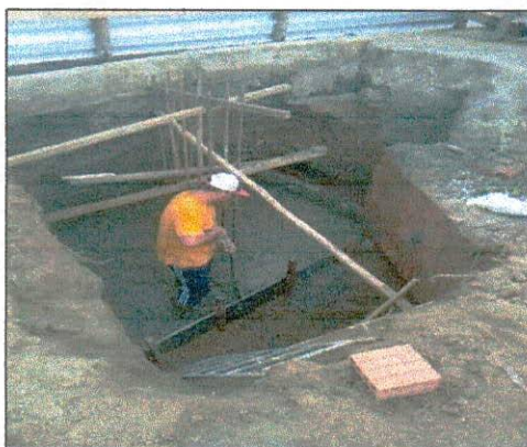
Foto 05: Concretagem de sapatas.
