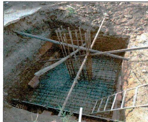
Foto 04: Armação de sapata e esperar de pilar sobre lastro de concreto
