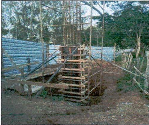
Foto 07: Montagem de formas pra concretagem dos pilares.
