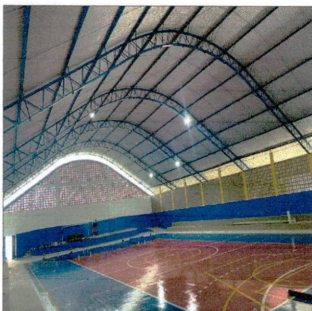
Foto 03: Execução de pintura epóxi do piso da quadra.
