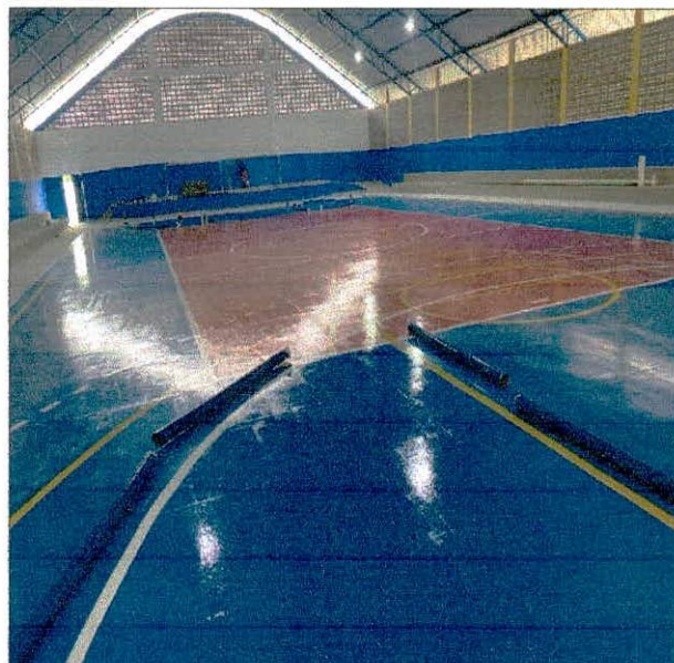
Foto 02: Execução de pintura epóxi do piso da quadra.
