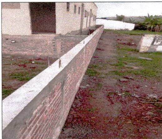
Foto 13: Execução de vigas de concreto.
