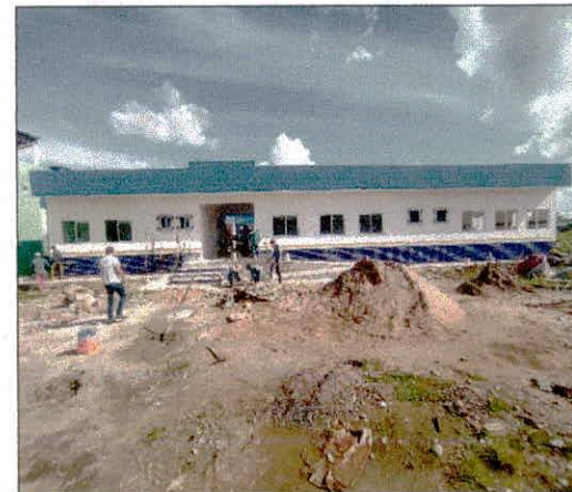
Foto 30: Execução de pintura e revestimentos acabados.
