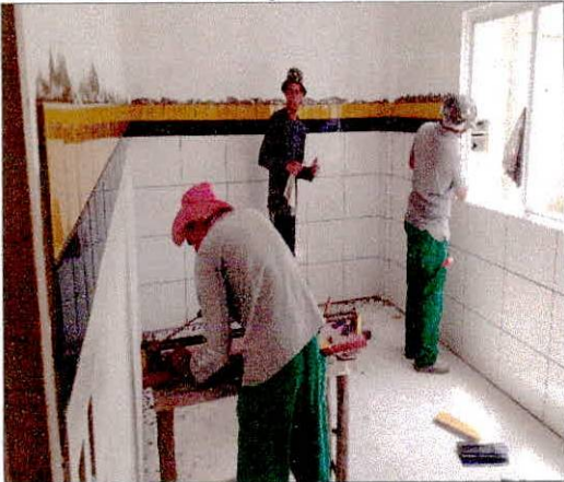
Foto 25: Execução de revestimento cerâmico em paredes.
