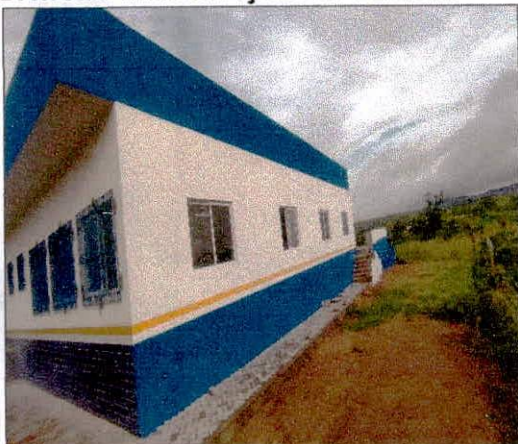
Foto 25: Execução de pintura externa finalizada.
