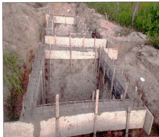
Foto 11: Execução de estruturas de concreto.
