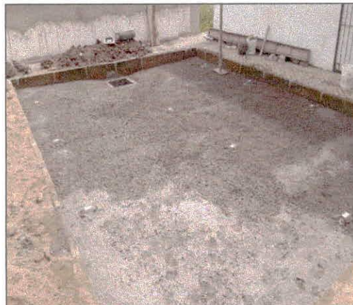
Foto 20: Execução de contrapiso em áreas do playground.
