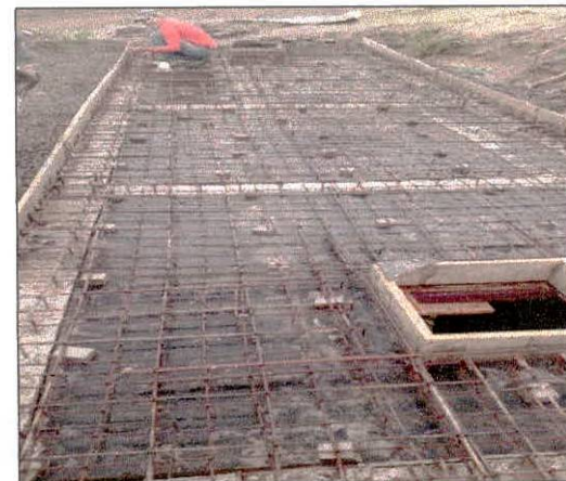
Foto 12: Armação para elaboração de estruturas de lajes.
