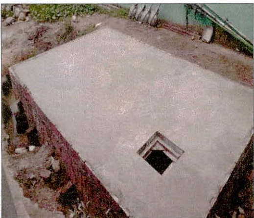
Foto 21: Laje do reservatório inferior executada.
