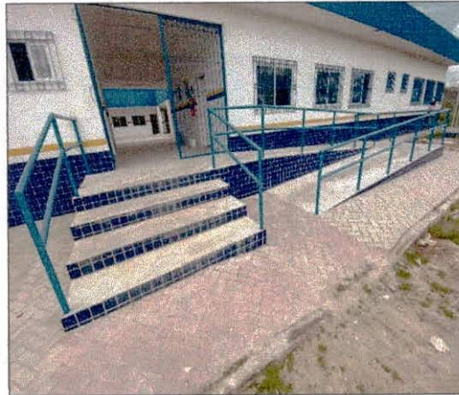
Foto 26: Pintura, revestimento cerâmico, piso intertravados e corrimãos instalados.
