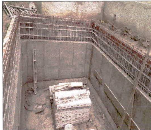
Foto 14: Concretagem de estruturas de concreto do reservatório inferior.
