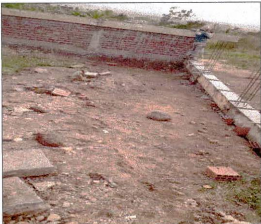
Foto 09: Embasamento da área de implantação dos playgrounds.
