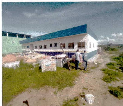
Foto 29: Pintura e revestimentos acabados.
