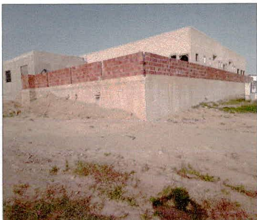
Foto 19: Execução de chapisco e revestimentos em argamassa das ampliações e playground.
