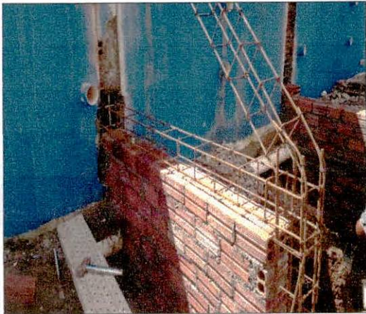
Foto 07: Embasamento de contrafortes.
