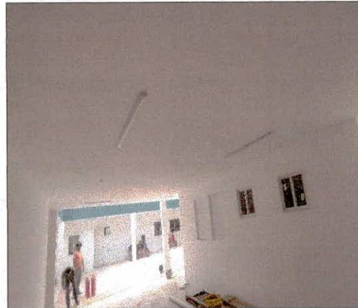
Foto 28: Pintura interna executada.
