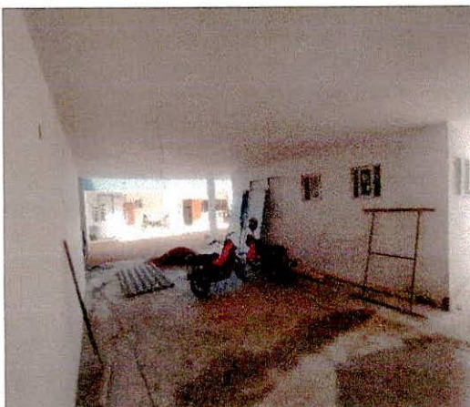
Foto 29: Execução de pintura.
