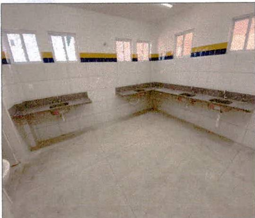
Foto 27: Pintura e revestimento interno executados.
