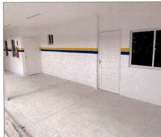
Foto 28: Revestimento cerâmico de ambientes internos executado.
