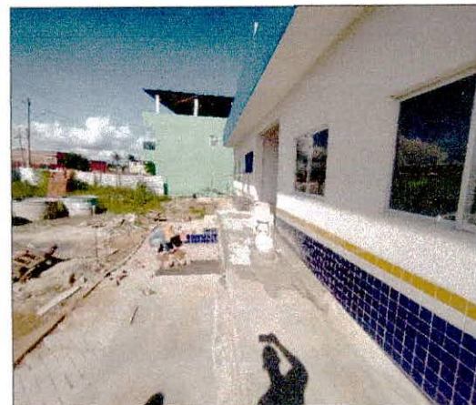
Foto 30: Execução de piso intertravados e pintura externa executada.
