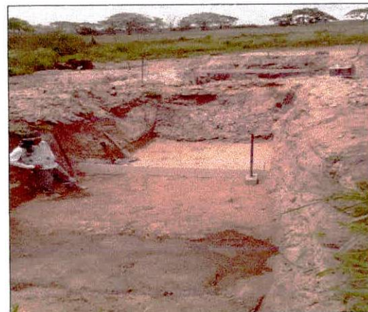
Foto 04: Escavações para fossa e sumidouro.
