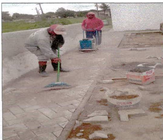
Foto 23: Execução de piso em intertravados.
