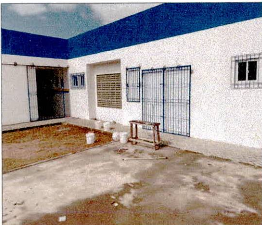
Foto 27: Grades de ferro instalados.
