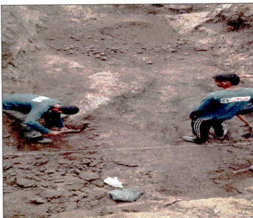
Foto 05: Escavações para construção do reservatório..
