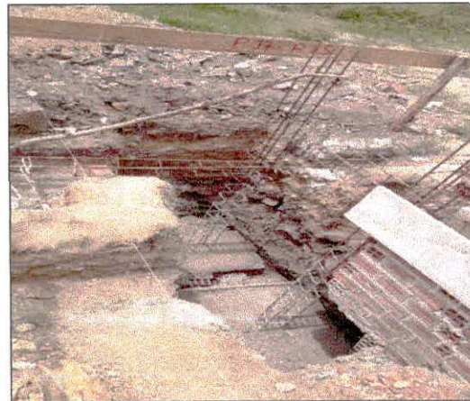
Foto 10: Execução de estruturas de concreto.
