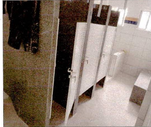
Foto 26: Divisórias de granito instaladas.
