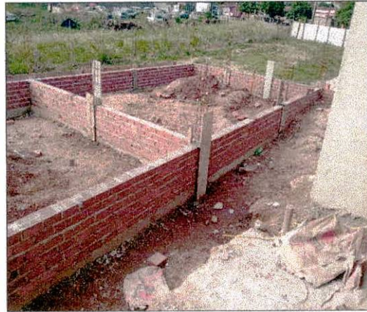
Foto 08: Embasamento das ampliações.
