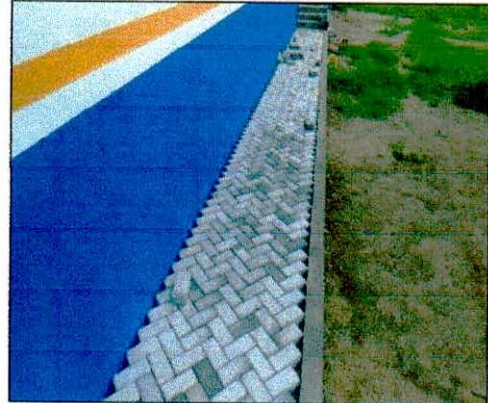
Foto 02: Execução de pisos em intertravados.
