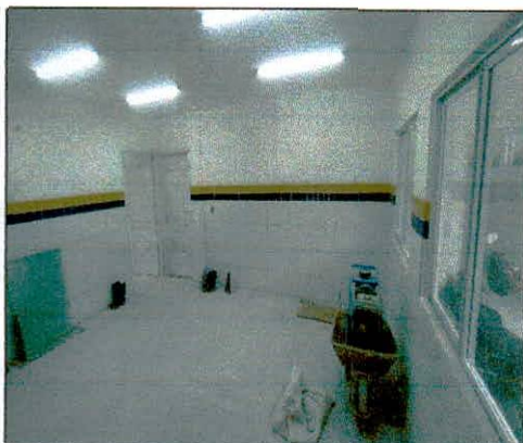
Foto 11: Interruptores, tomadas e luminárias instalados.
