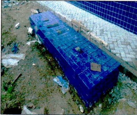
Foto 01: Execução de base para mastros.
