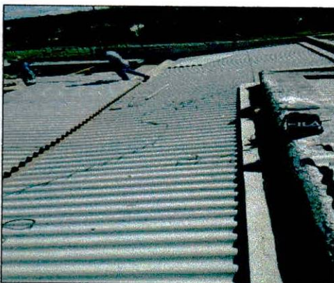
Foto 05: Coberta com calhas e rufos executados.
