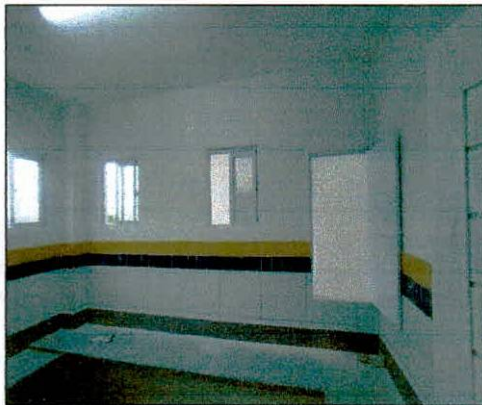
Foto 07: Portinholas e janelas de alumínio instaladas.
