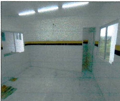
Foto 09: Interruptores, tomadas e luminárias instalados.
