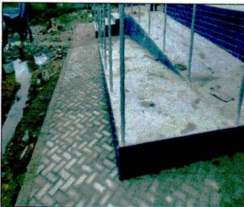
Foto 03: Passeios em intertravados executada.
