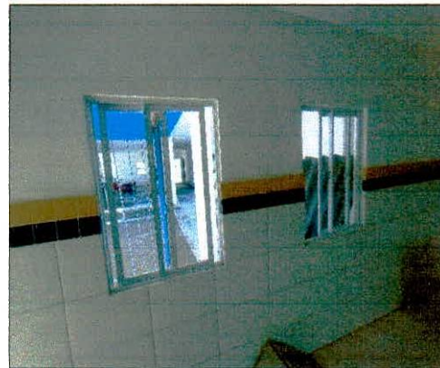
Foto 08: Janelas de Alumínio instalados.
