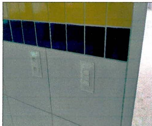
Foto 10: Interruptores, tomadas e luminárias instalados.
