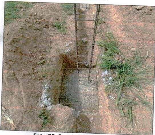
Foto 09: Sapatas concretadas.
