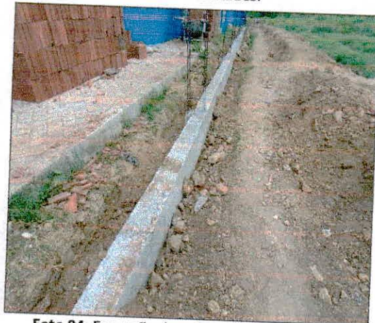
Foto 04: Execução das vigas baldrame do muro.
