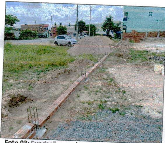
Foto 03: Fundações, embasamento, e reaterros do muro executados.
