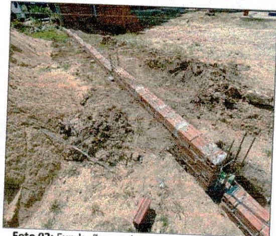
Foto 02: Fundações, embasamento, e reaterros do muro executados.
