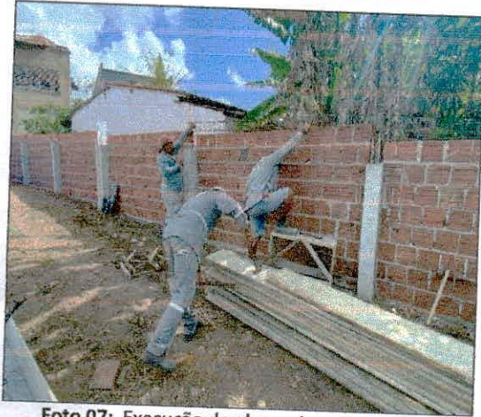
Foto 07: Execução de alvenarias muro do lado direito da creche.
