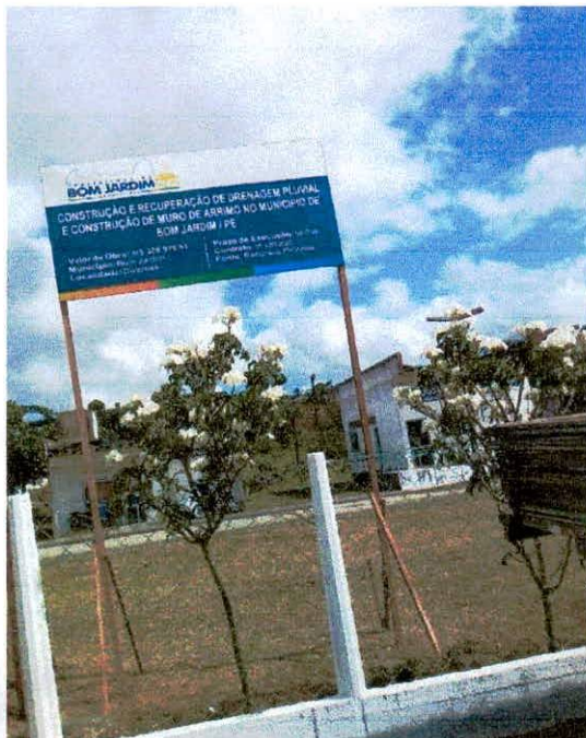
Placa de obra Foto 3
