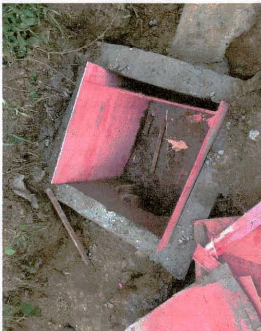
Construção de caixa de concreto armado Foto 7
