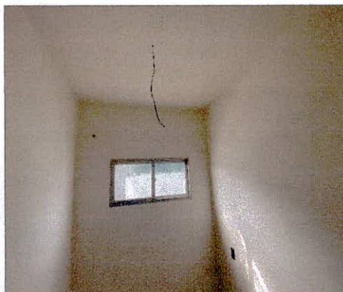
Foto 05: Aplicação de fundo selador em paredes e tetos.
