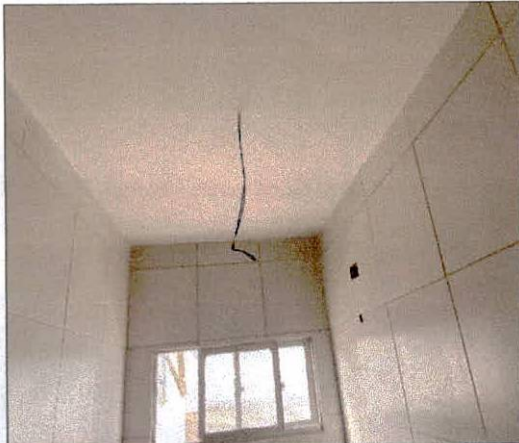
Foto 01: Forro de gesso aplicado em ambientes.
