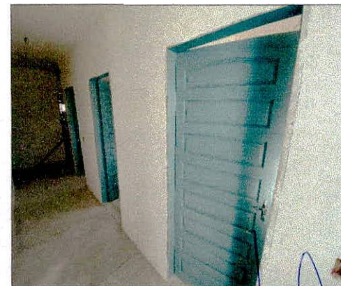
Foto 06: Aplicação de fundo selador e pintura de portas executados.
