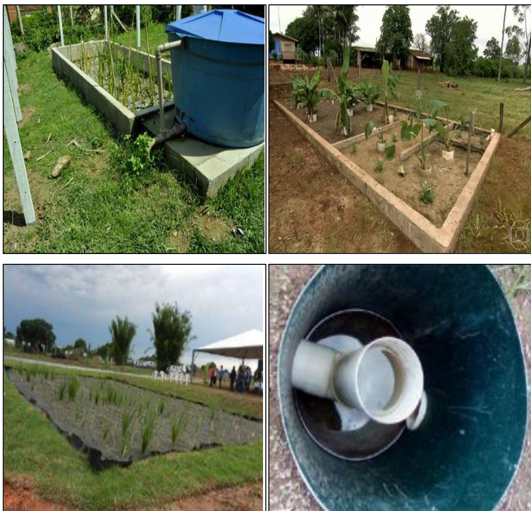
Figura 64 - Esquema de zona de raízes ou SAC.
