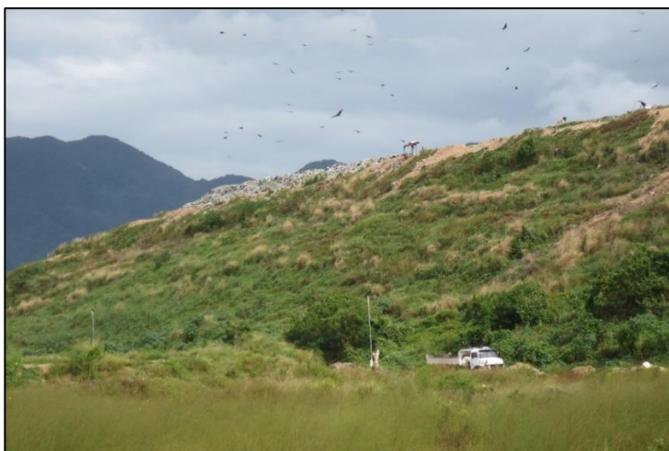
Figura 43 - Exemplo de aterro controlado.
