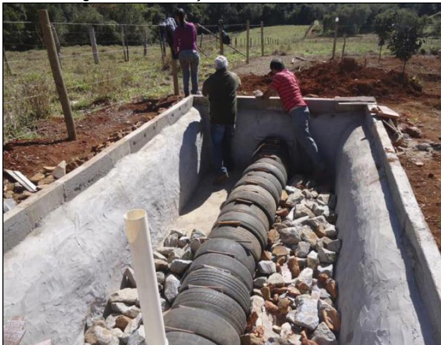
Figura 70 - Construção de círculo de bananeira.
