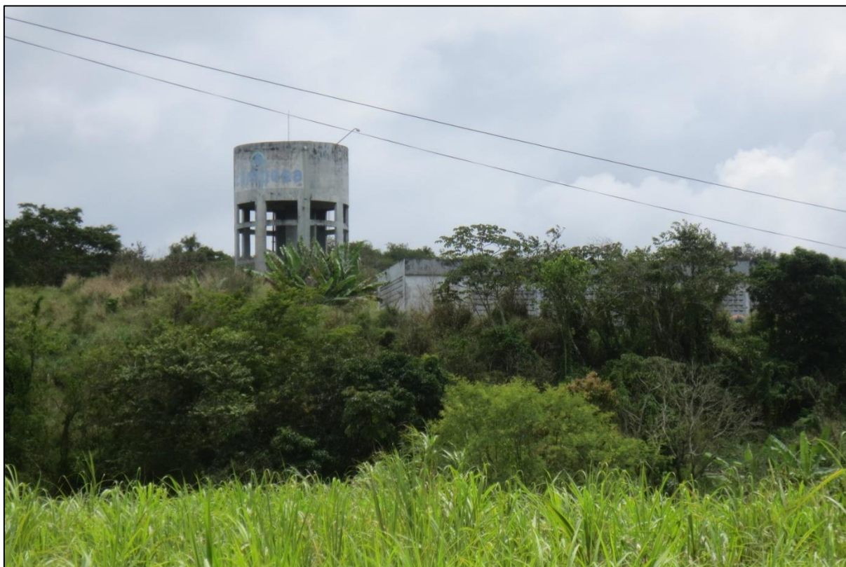
Figura 25 – Reservatório de água elevado.
