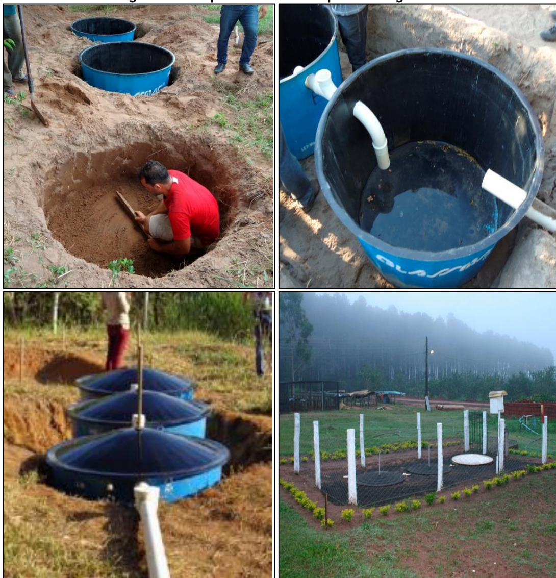
Figura 62 - Esquema da fossa séptica biodigestora.
