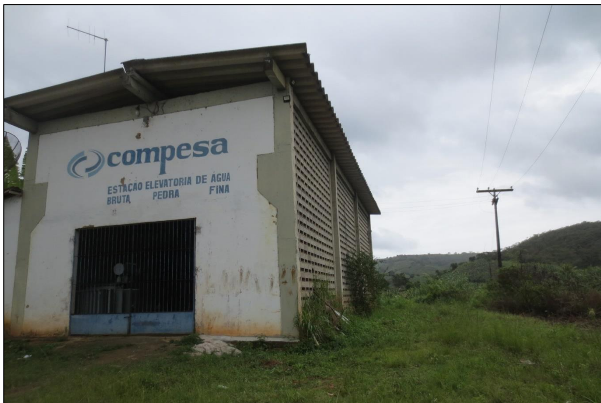
Figura 19 - Estação elevatória da Barragem Pedra Fina (Palmeirinha).
