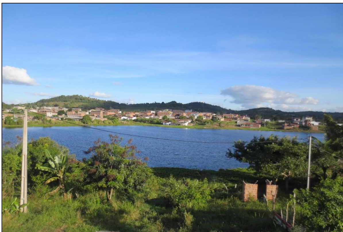
Figura 20 - Barragem do Distrito de Encruzilhada.
