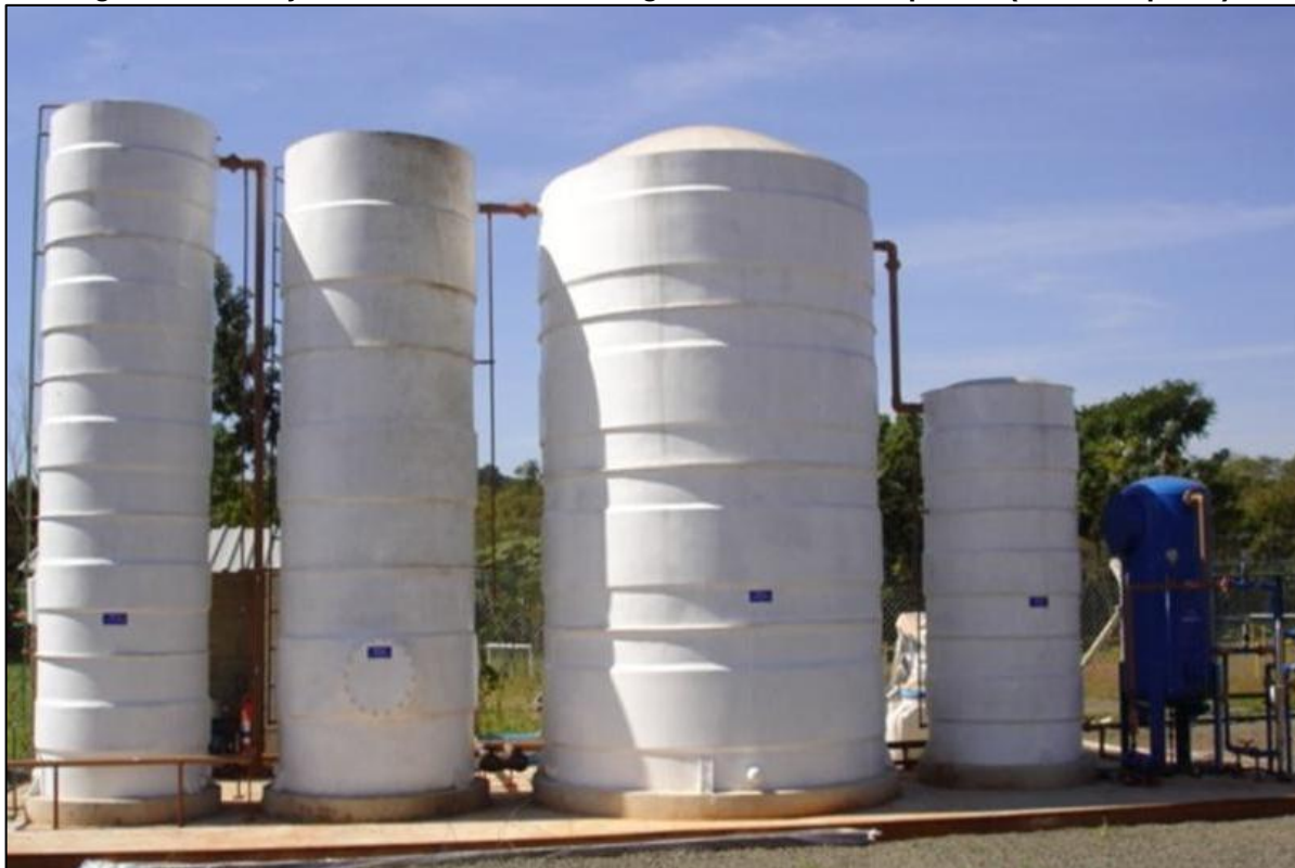
Figura 60 - Estações de Tratamento de Esgoto Sanitário Compactas (ETE Compacta).
