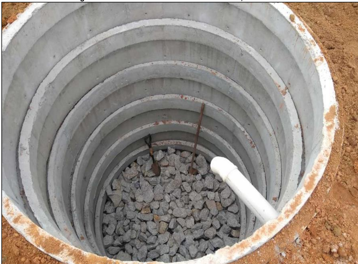
Figura 59 - Sistema individual de tratamento, sumidouro.
