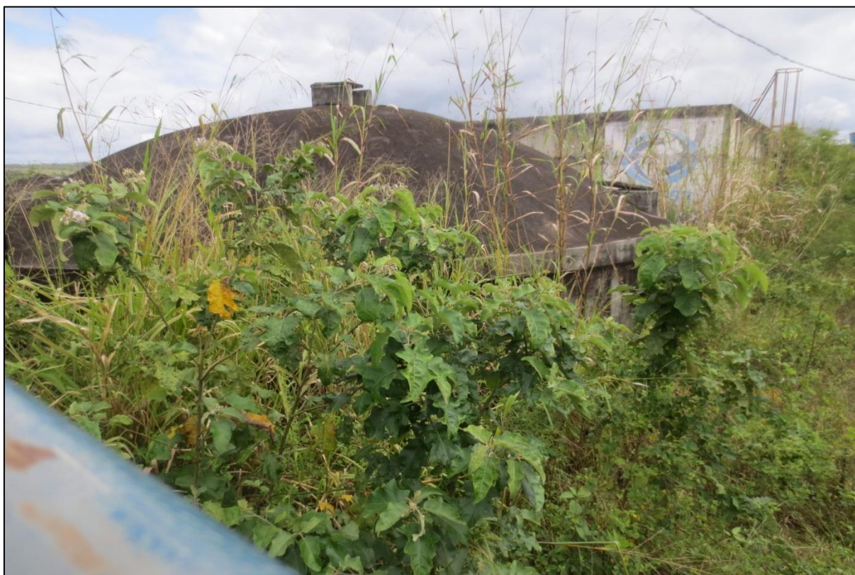
Figura 26 - Reservatório de água enterrado.
