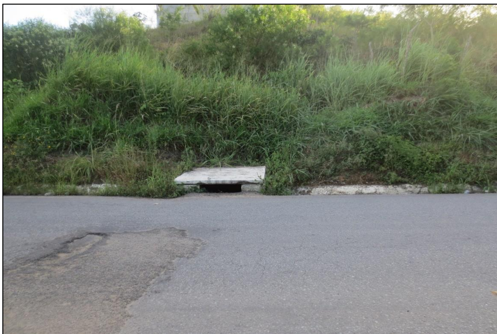
Figura 51 – Microdrenagem no município de Bom Jardim.
